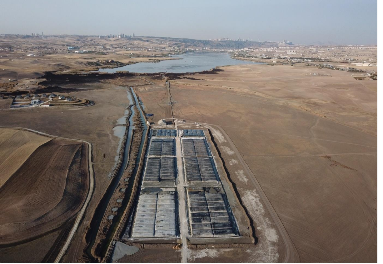
Şekil 2.20. Mogan gölü dip temizleme projesi
