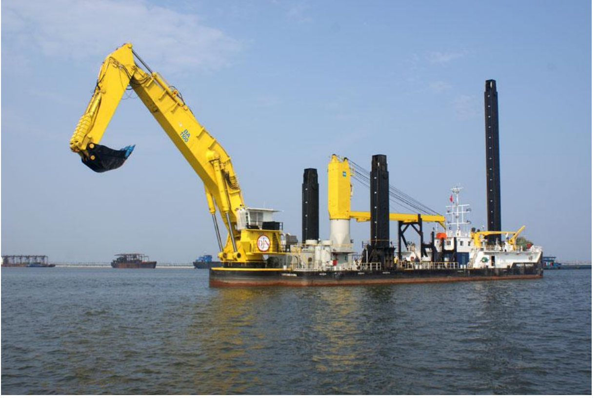
Şekil 2.5. Yüzer ekskavatör (backhoe dredger) (demir kazıklı)
