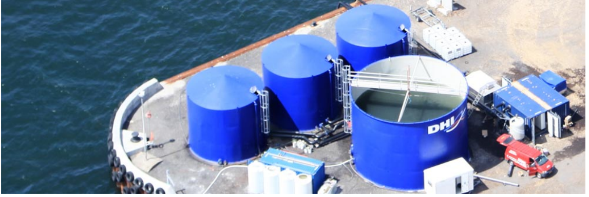
Şekil 5.3: DHI Ballast Water Centre- Danimarka, Hørsholm
